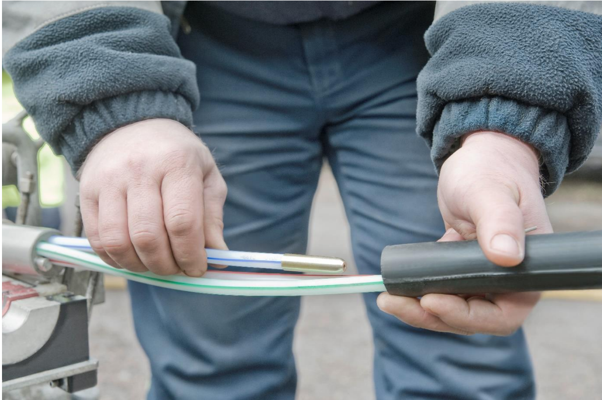
Abbildung 1: Einführung von Kabeln in ein Leerrohr Quelle: REHAU AG + CO
