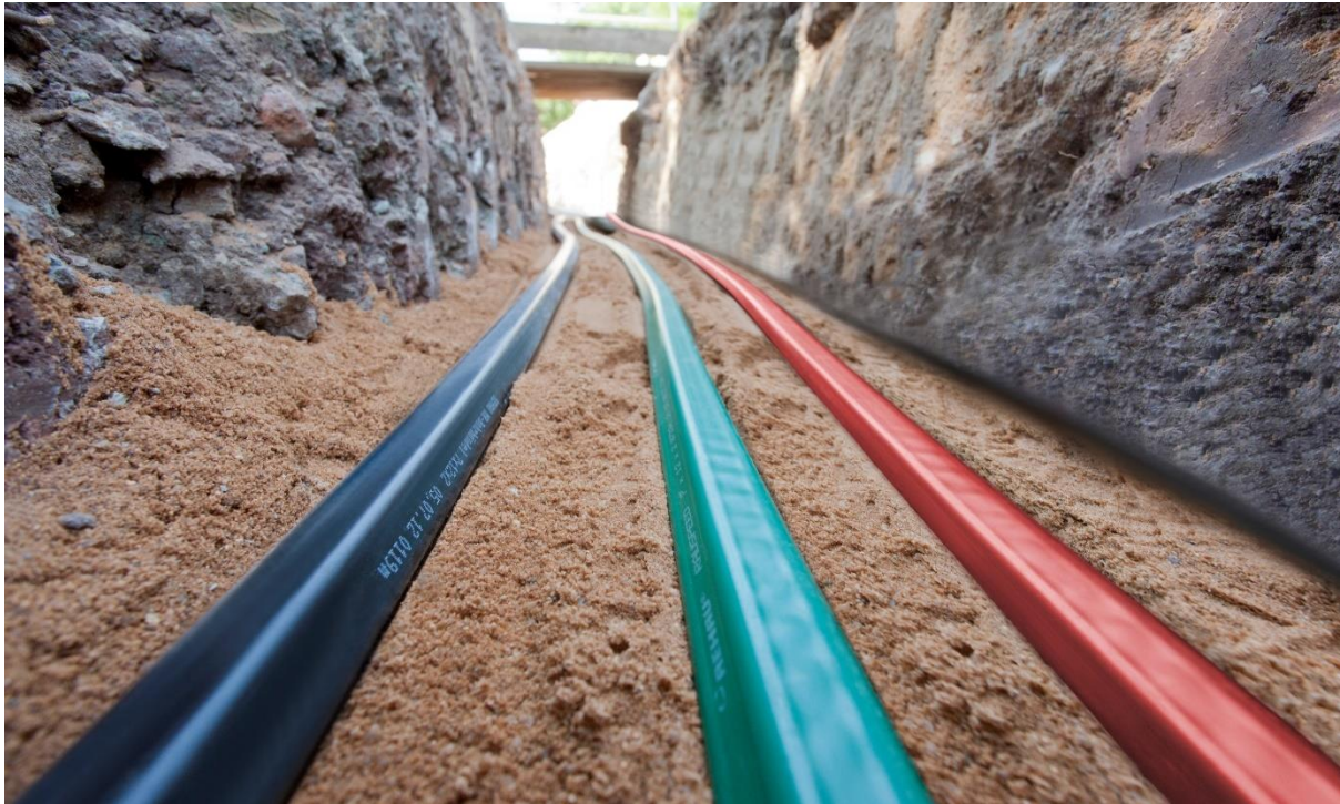
Abbildung 8: Tiefbau; Quelle: REHAU AG+Co
