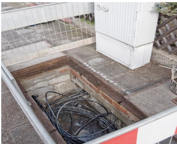
Abbildung 2: Kabelschacht mit KVz; Quelle: REHAU AG+Co
